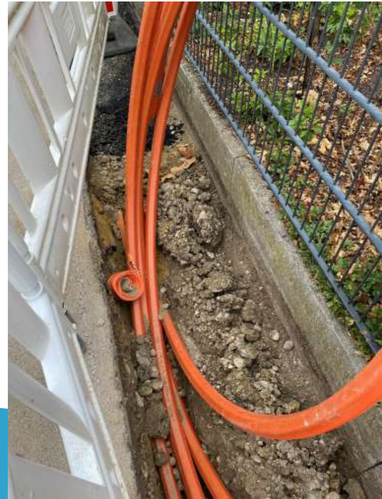
Verlegung Speedpipe
