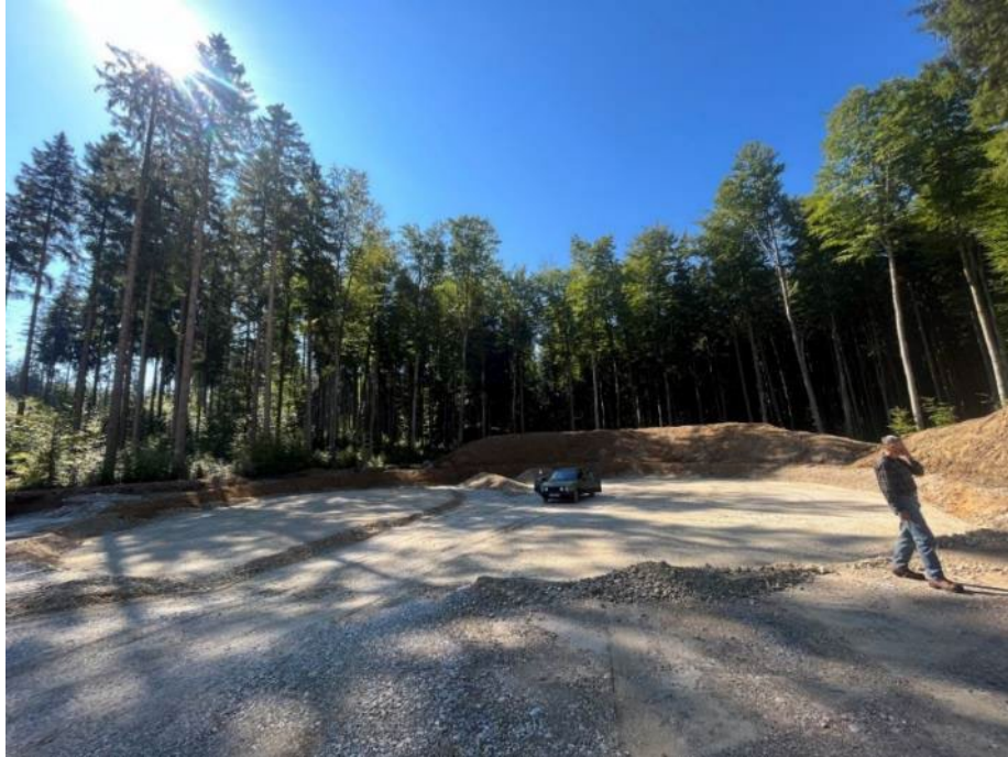
Abbildung: Vorbereitete Fundamentfläche in der Gemeinde Fuchstal
